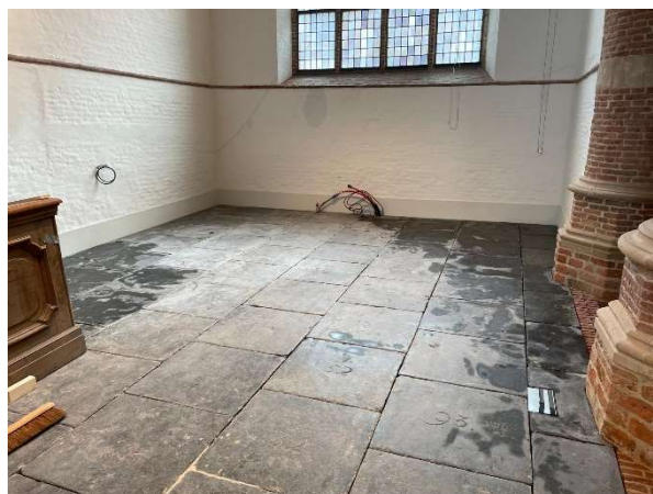
Foto 2: De zerkenvloer (zuidzijde)
